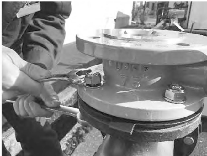
短いスパナ2本で締め付けられるため、狭いスペース内でも施工しやすい
