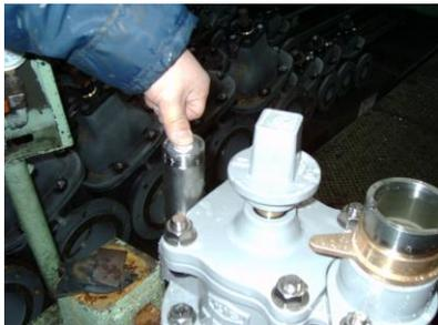
10. 8角キャップを取り付け、プライヤーで軽く締め付けてください。
