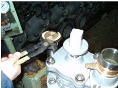
11. 補修弁を開け、漏水がないかチェックして作業終了です。
