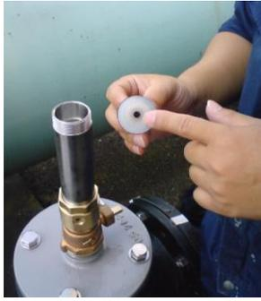
7. フロート部先端の円錐ゴムとの当たり部分のゴミを取り除き、ゴムとの当たり面に傷がついていないか確認して下さい。
