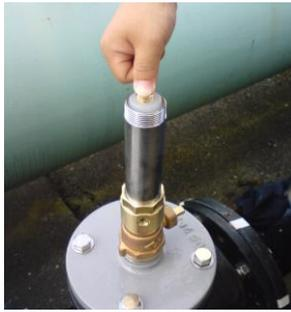
9. 8角キャップを取り付け、プライヤーで軽く締め付けてください。(手で開けられない程度)
