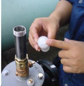
8. フロート、弁座押えの順番に取り付けて下さい。弁座押えは斜めにならないように確実に押し込んでください。
