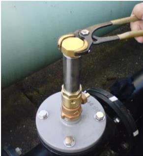
10. 分解の逆手順で、ステンレスカバーを本体に被せ、作動チェック弁を取り付けます。
